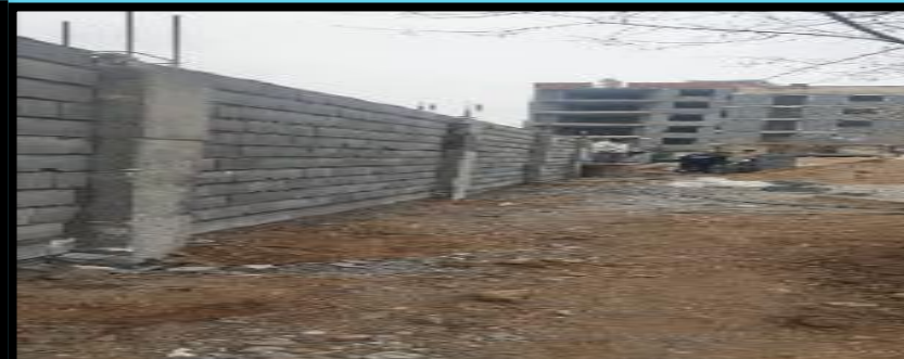
دیوار کشی محوطه شهرداری منطقه ۲
