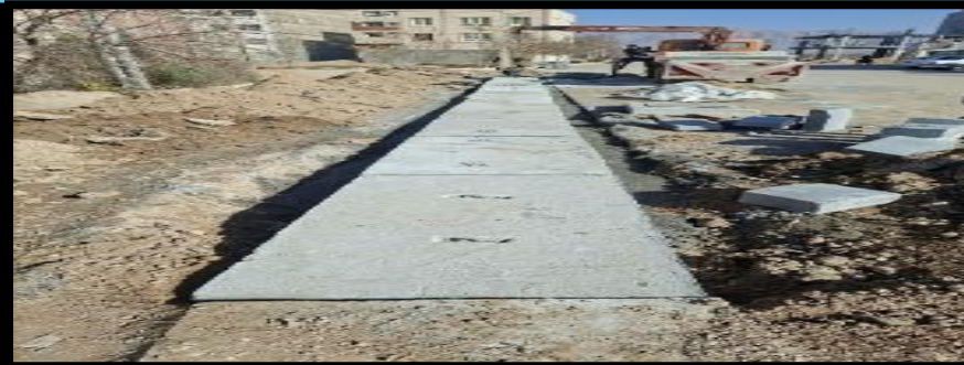
اجرای دال بتنی
