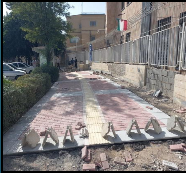
پیاده رو سازی معابر سطح شهر
