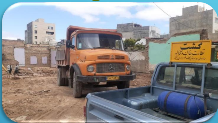
گشت ستادخاک ونخاله ساختمانی
